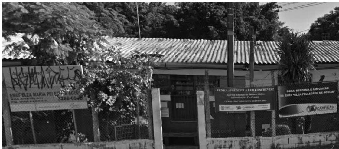
Figura 2 Aspecto geral da fachada da EMEF Profa. Elza Maria Pellegrini de Aguiar
